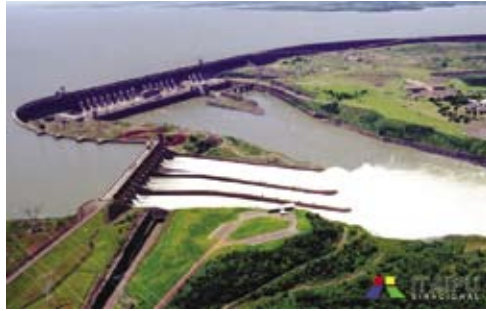
Foto 1 - Usina Hidrelétrica de Itaipu, PR
