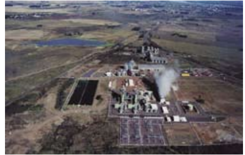
Foto 2 - Termoelétrica de Uruguaiana, RS
