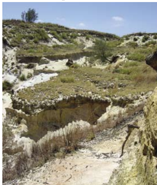
Foto 1 - Erosão pluvial em terreno sedimentar.
